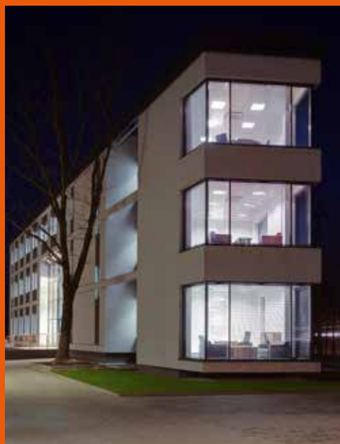
Budynek firmowy Delta Service ul. Marecka 66A, Zielonka
