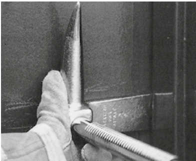
Otwieranie przegród drzwiowych i okiennych
